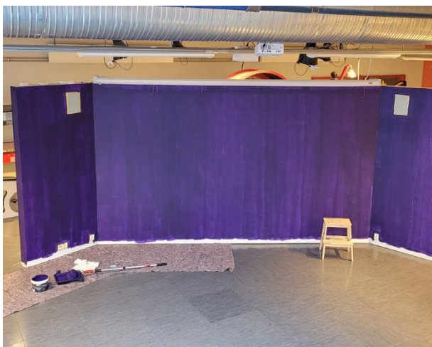
Ny vegg med innebygget AV-anlegg.
